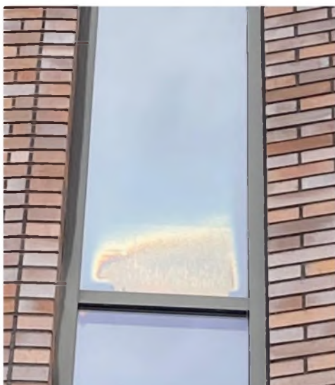
Рисунок 5. Химический конденсат внутри стеклопакета
